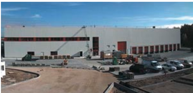
Im Logistik-Neubau von Simon Hegele bei Nürnberg werden Produkte des Siemens Energy Sectors gelagert, kommissioniert und der Fertigung zugeführt.
