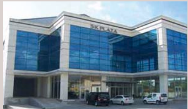
Das neue Logistik Center der IT Chain und Simon Hegele in Istanbul.
